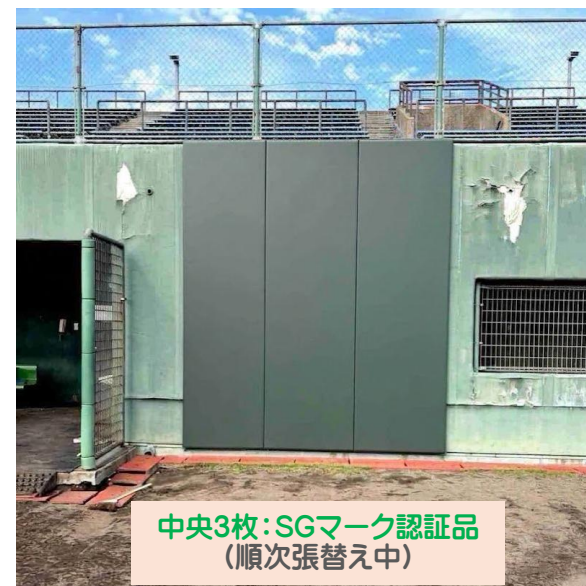
野球場での緩衝パッド施工事例
